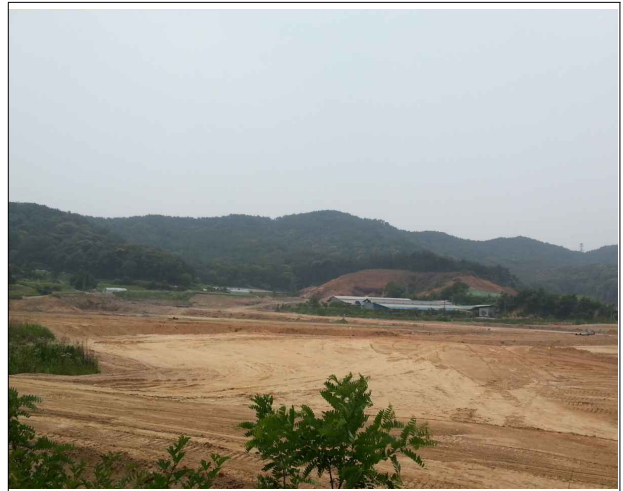
[공사 중 전경]
